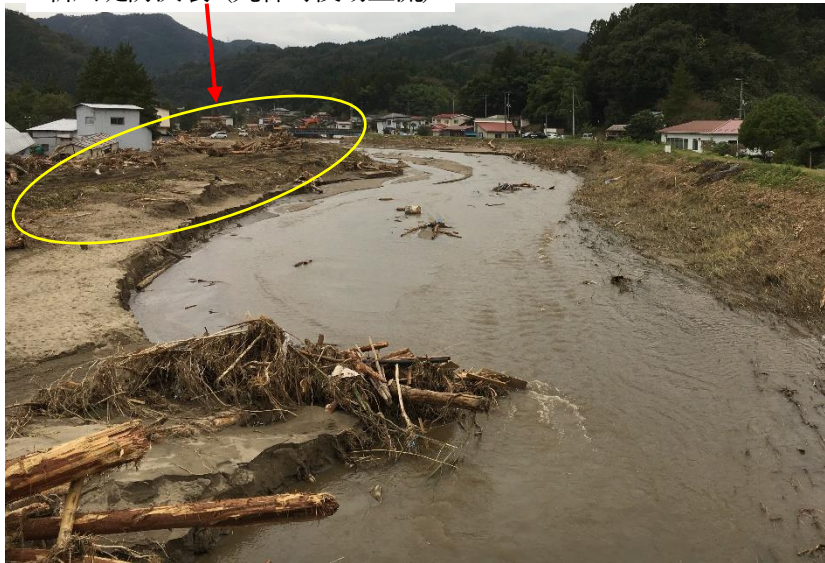
新川堤防決壊（丸森町役場上流）
